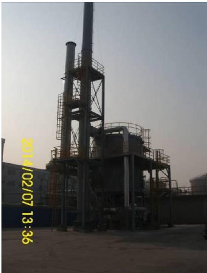
公司为减少VOCs排放对周边环境的影响，于2013年投资680万元新建了尾气处理装置，RTO燃烧炉，此装置有效降低公司制程中VOCs对周边环境的影响。
