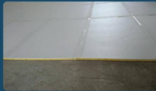
▲ 接縫處使用封箱膠帶黏貼做防水處理
