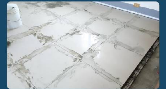
▲ 磁磚縫隙及牆面接縫進行填縫處理
