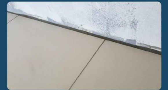
▲ 將牆面接縫處之多餘隔離板切除
