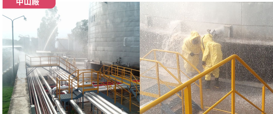
中山廠 2022 年緊急應變演習一 SM 管線洩漏事故演練
