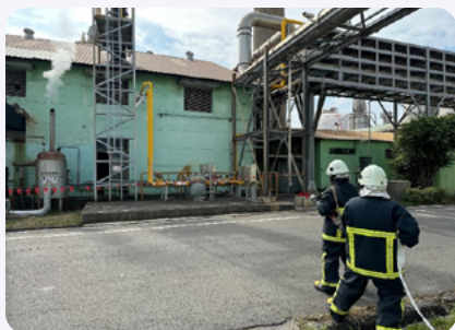
前鎮廠 - LNG 計量站洩漏之火災緊急應變處理
