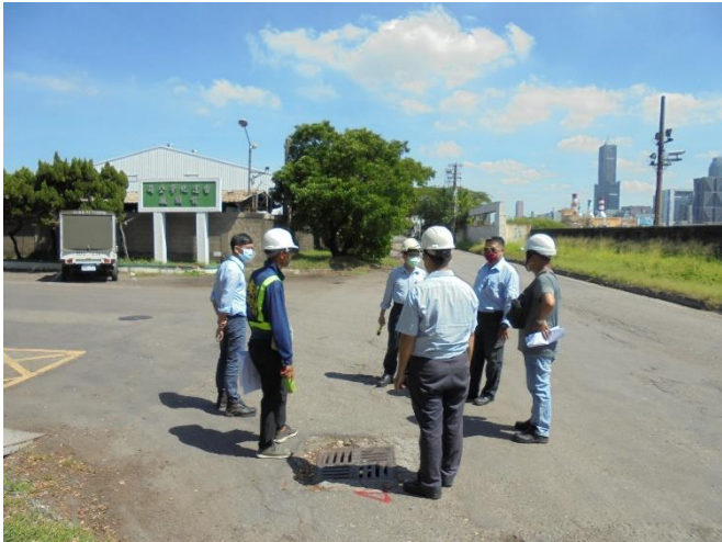
施工廠商於建基街實地現勘作業
