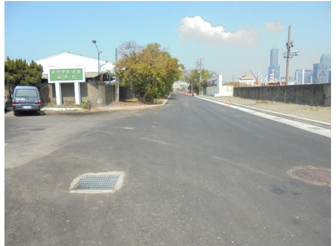
建基街柏油地面重新鋪設完成
