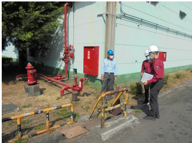
實地抽檢廠區消防設備
