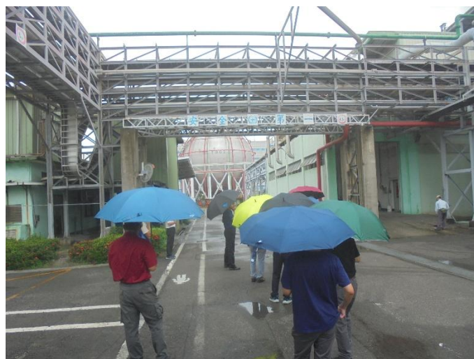
航港局進行廠區巡檢作業
